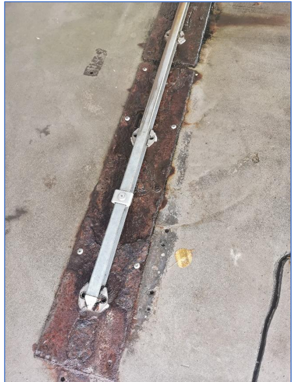
Abbildung 3: Ankerplatte mit Laufschiene Quelle: eigene Darstellung
