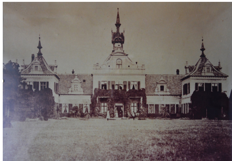
Schloss Zerben. 1948/49 wurde zur Gewinnung von Baumaterial der Mittelteil des Schlosses abgerissen. Die Seitenflügel wurden 2010 nach der Restaurierung als Museum wiedereröffnet.
